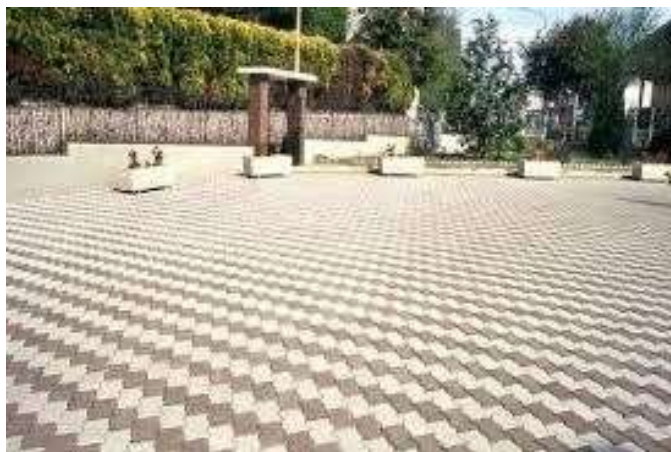
Figura 11 – Esempio di Pavimentazione in masselli autobloccanti;
