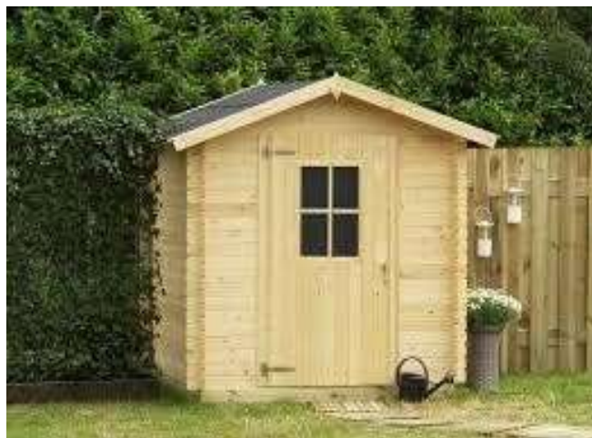
Figura 6 – Esempio di mini casa in legno;
