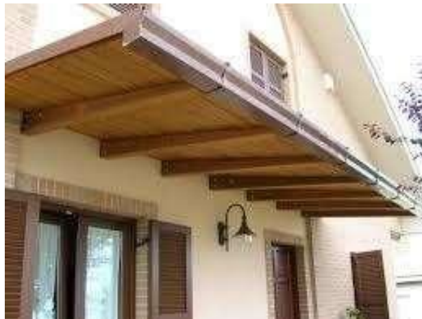
Figura 10 – Esempio di Tettoia a sbalzo
