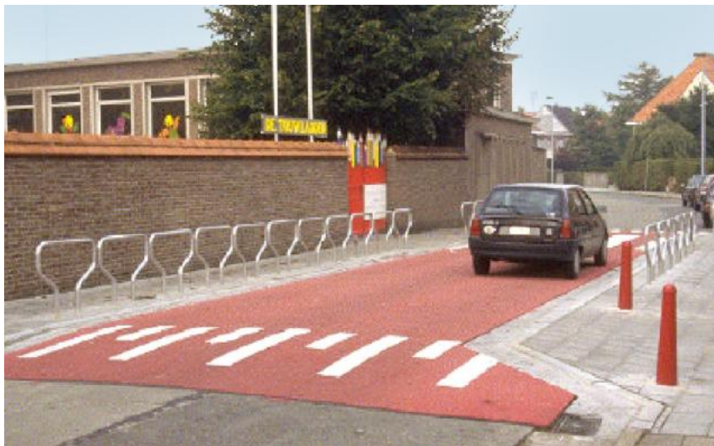
Figura 112 - Piattaforma rialzata con attraversamento pedonale (fonte: https://docplayer.it/1877176-Gli-atteversamenti-pedonali-rialzati.html )
