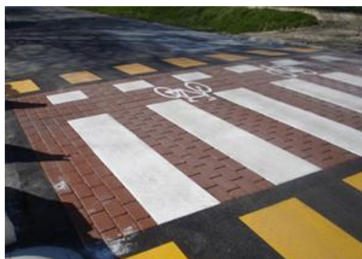
Figura 128 - Esempio di trattamento di irruvidimento superficiale e di attraversamento in asfalto stampato
