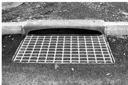
Figura 127 - Esempio di canalina per ciclisti e di griglia in favore della mobilità ciclistica
