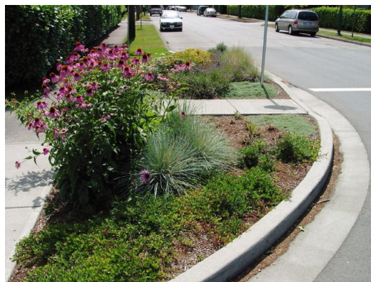
Figura 121 - Esempi di allargamenti dei marciapiedi in corrispondenza delle intersezioni stradali con elementi di arredo (fonti: https://nacto.org/publication/urban-street-design-guide/street-design-elements/curb-extensions/gateway/ ; http://newLawrenceheights.ca/blog/new-sustainable-place.php )
