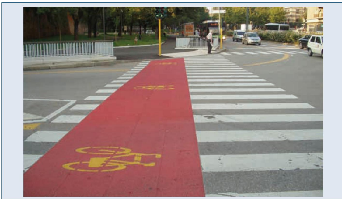
Figura 98 - Attraversamento ciclo-pedonale (Vademecum della ciclabilità - Regione Puglia)
