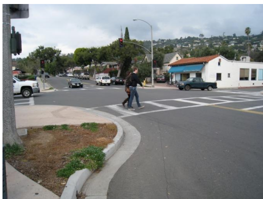
Figura 121 - Esempi di allargamenti dei marciapiedi in corrispondenza delle intersezioni stradali con elementi di arredo (fonti: https://nacto.org/publication/urban-street-design-guide/street-design-elements/curb-extensions/gateway/ ; http://newLawrenceheights.ca/blog/new-sustainable-place.php )
